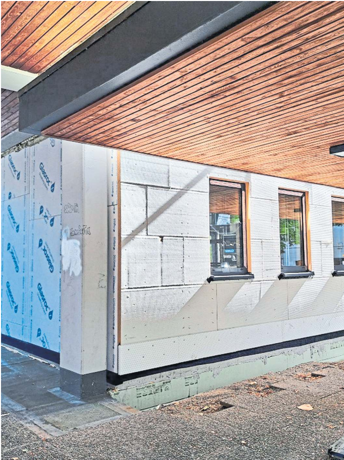
Der Erweiterungsbau der neuen Mensa ist von außen weit fortgeschritten. Foto: Gaby Kiedaisch
