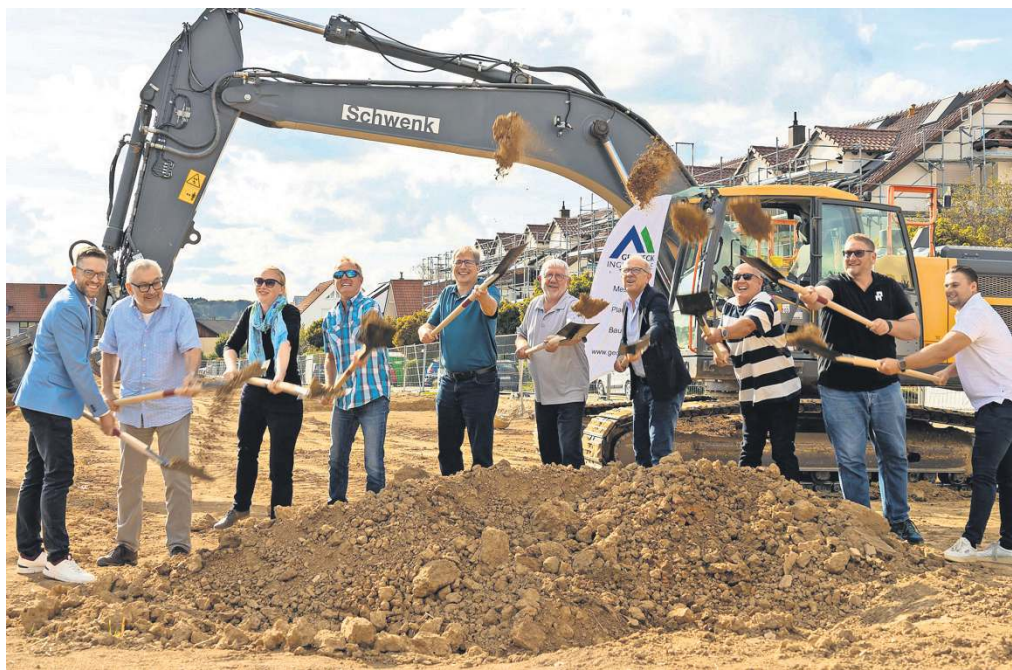
Für alle Beteiligten ein besonderer Moment: Der Spatenstich markiert den offiziellen Beginn der Erschließung. Foto: Tim Kirstein
