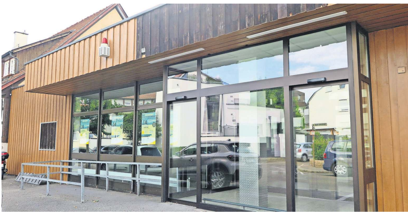
Im ehemaligen CAP-Markt soll eine Nachbarschaftskantine entstehen.
