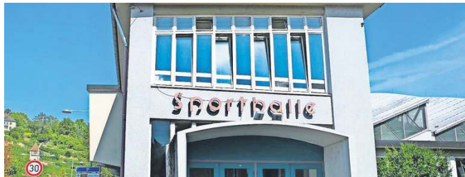
Die Sanierung der denkmalgeschützten Schelztorsporthalle in Esslingen erhält einen hohen Fördermittelbetrag. Foto: Ines Rudel
