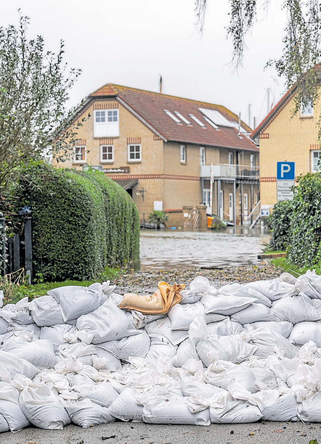
Wenn Sandsäcke nichts mehr ausrichten, kann es zu schweren Schäden an Gebäuden kommen. Foto: djd/DEVK/Benjamin Nolte
