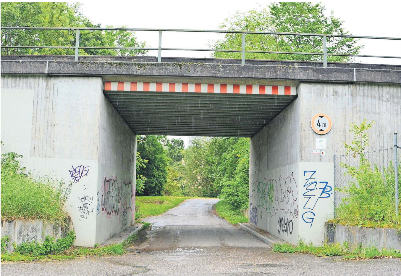
Die bestehende Unterführung könnte auch für den Radschnellweg genutzt werden.
