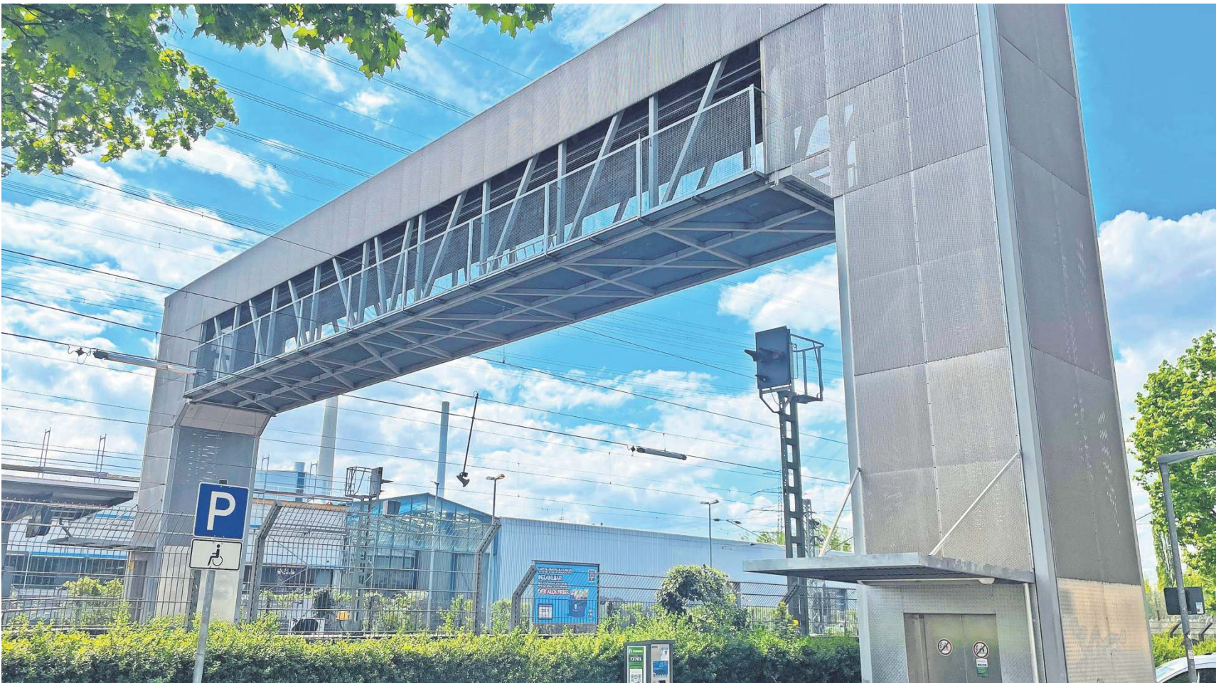
Der Peoplemover in Altbach gilt als einzigartiges Ingenieursprojekt. Der Aufzug fährt seitlich über die Gleise.
