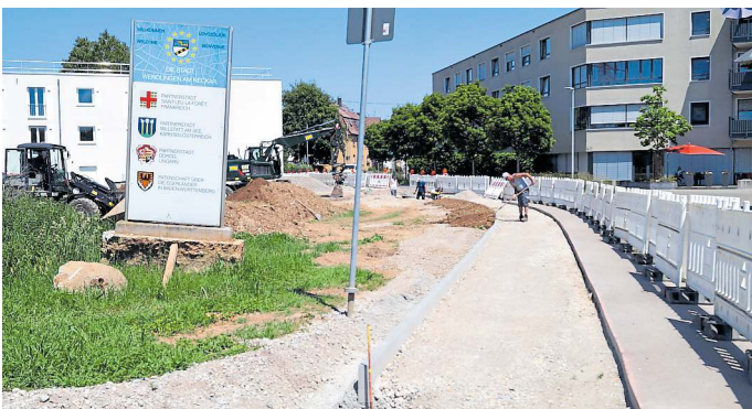
Der neue Rad- und Gehweg wurde bereits geschottert und verdichtet.
