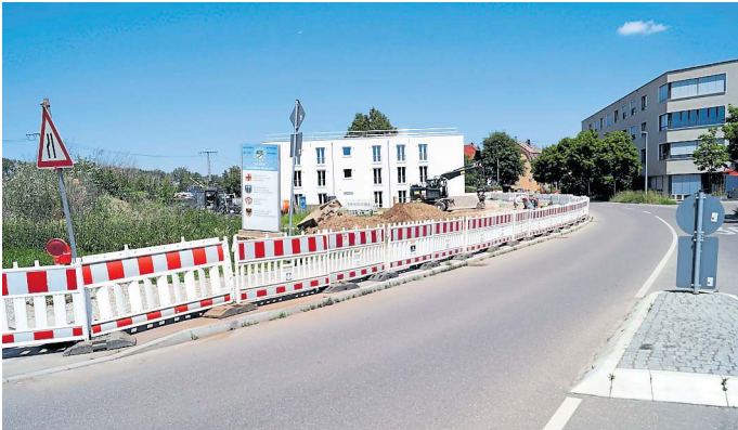
Die Nürtinger Straße stadteinwärts.
