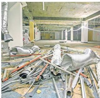
Das Gebäude wird bis auf den Rohbau entkernt.
