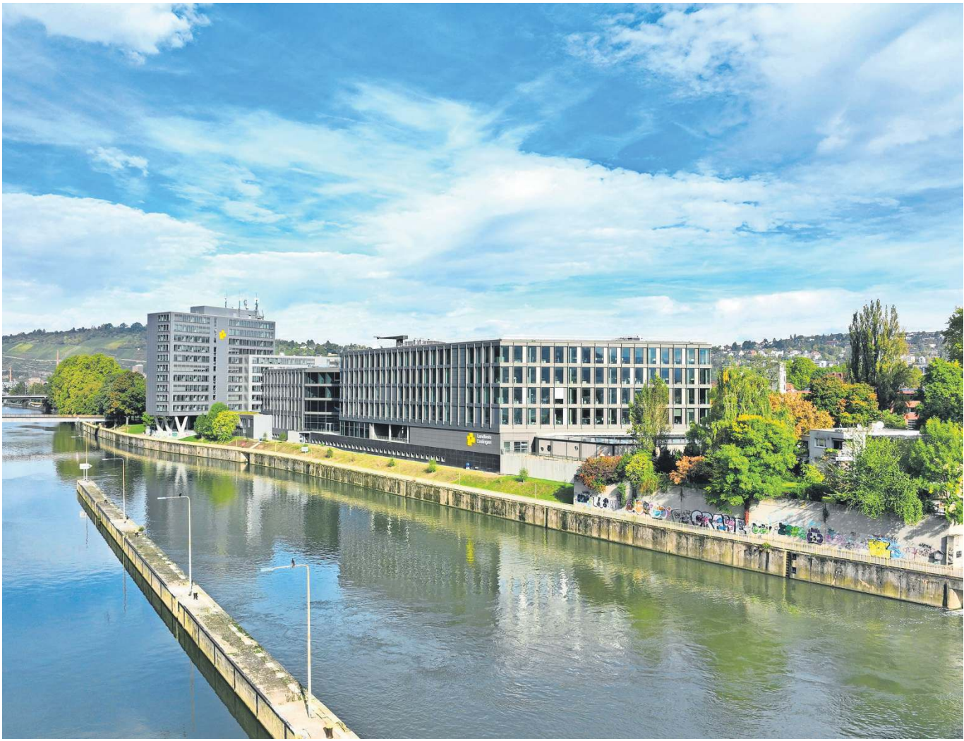
Das Landratsamt in Esslingen hat einen Neubau bekommen (im Vordergrund).
