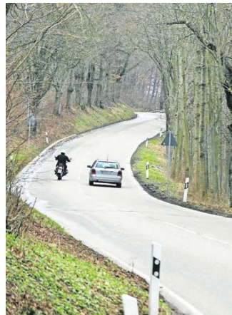
Die Ochsenwanger Steige wird wegen Hangsicherungsarbeiten halbseitig gesperrt.
