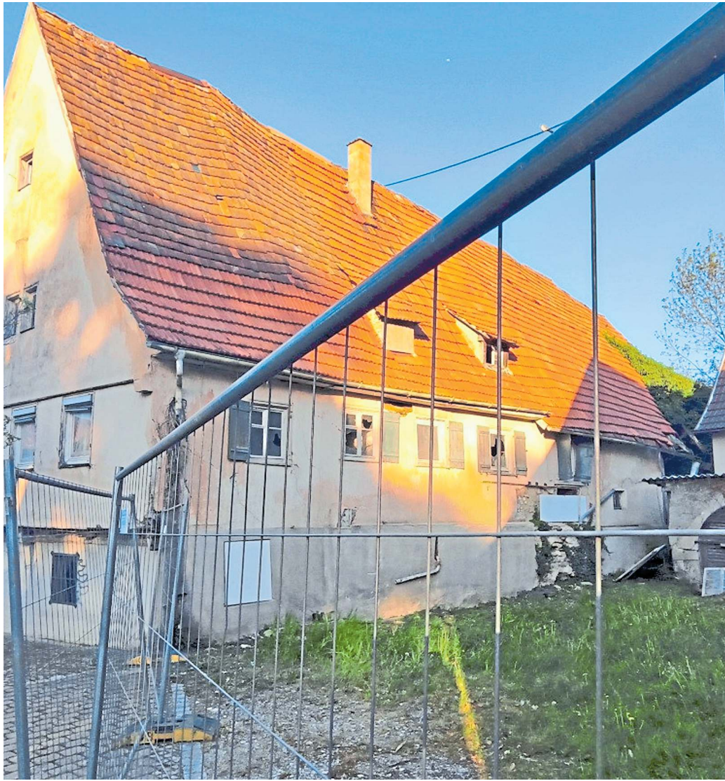
Seit Jahren findet sich kein Käufer für das Ensemble Stocknachstraße 9 (Bild) und 11.
