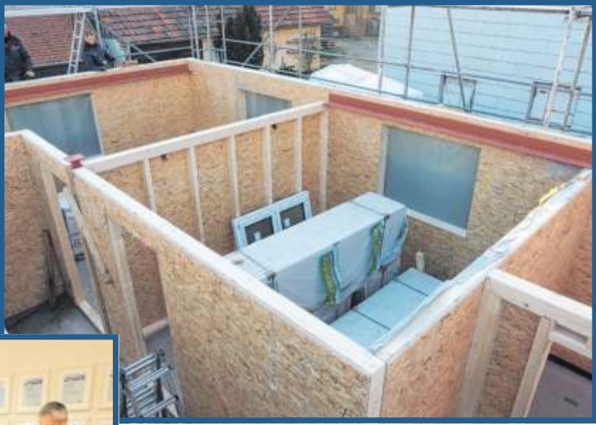
Nachhaltig, flexibel und energieeffizient: Im Holzrahmenbau entstehen leichte, stabile und gut gedämmte Gebäude. Ideal für moderne Wohn- und Gewerbebauten – schnell, umweltfreundlich und langlebig.
