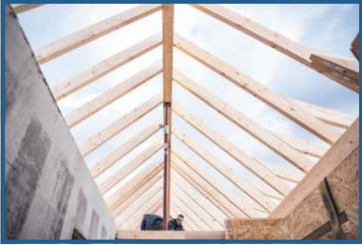
Neuer Dachstuhl im Aufbau – präzise Zimmererarbeit auf der Baustelle
