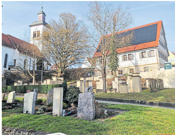
Das sanierte Alte Rathaus ist nicht nur ein Kulturdenkmal, sondern ist neben der Michaelskirche das Wahrzeichen der Gemeinde. Auf dem Dach eine moderne Photovoltaikanlage. Foto: Astrid Diels
