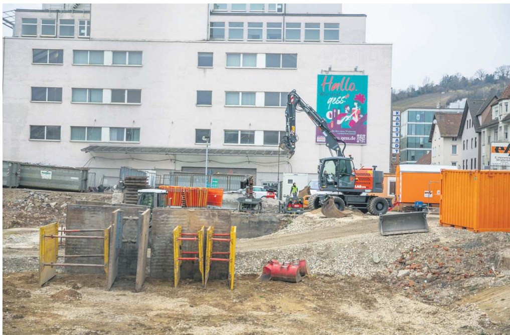
Einige Arbeiten laufen schon auf dem Esslinger Karstadt-Areal.
