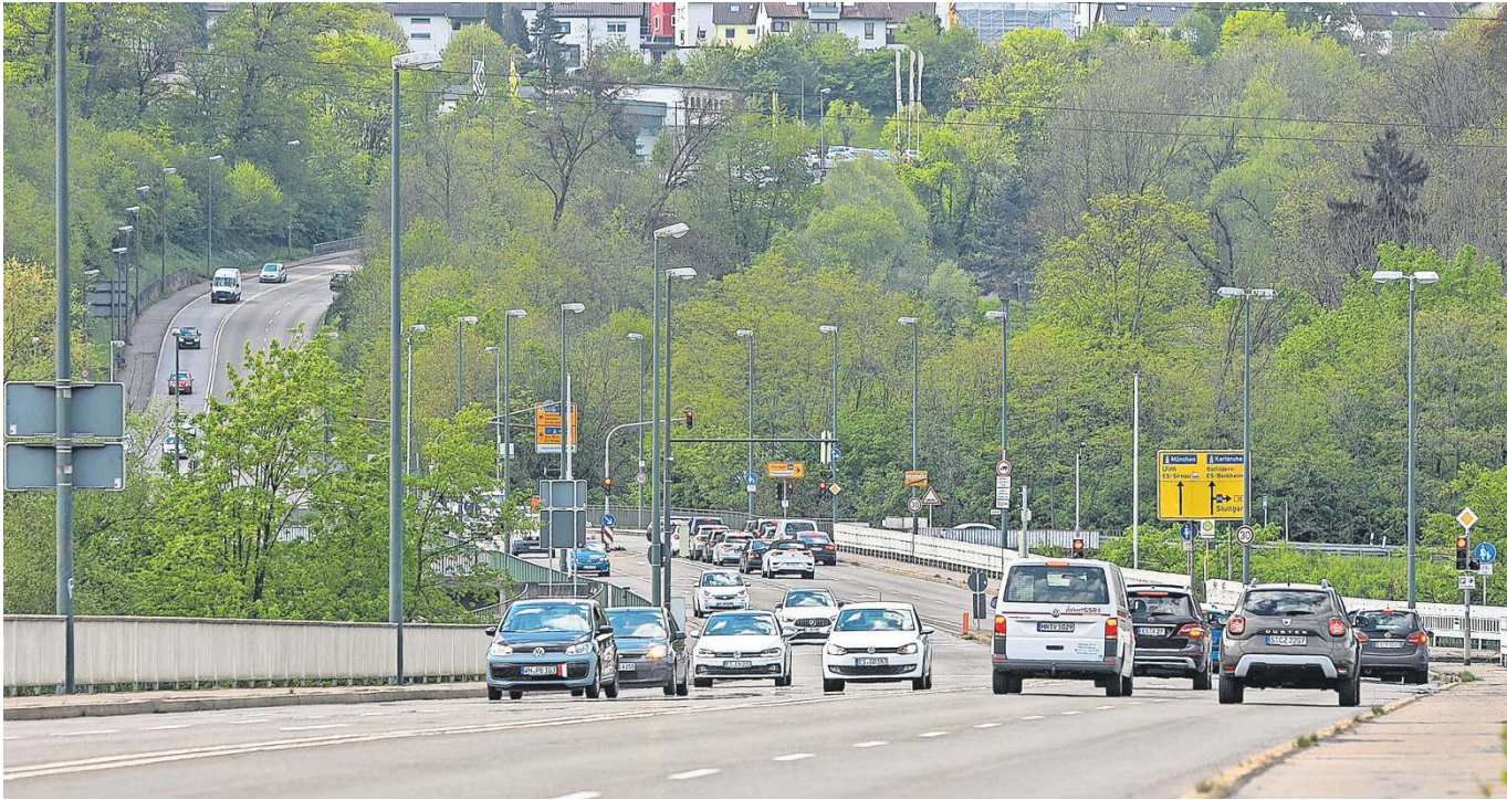
An der Adenauerbrücke wurden Schäden entdeckt. Vorsorglich wird ein Abschnitt gesperrt.
