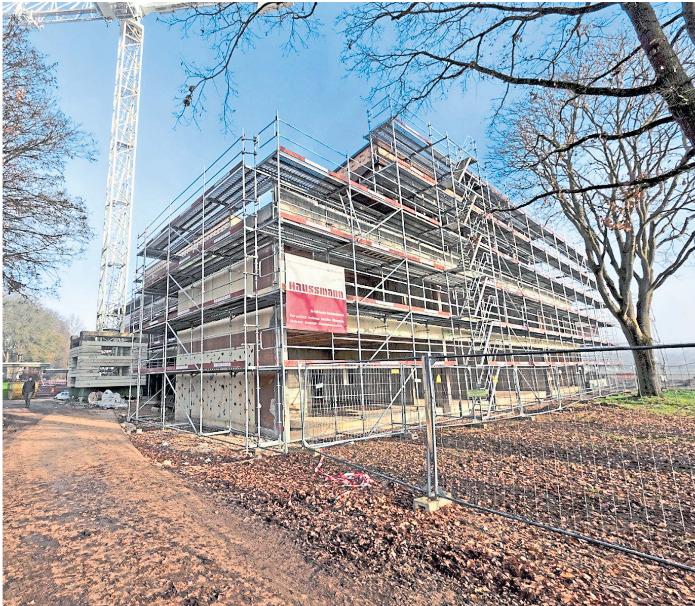
Die Sanierung der Liebenauschule ist ein großer Batzen im Haushalt.
