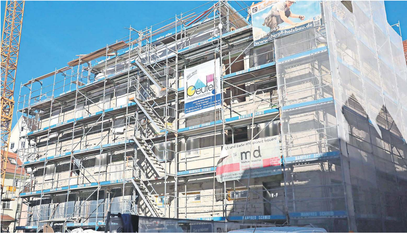
Bei der Restaurierung des Gebäudes Adlerstraße 2 wird innen und außen mit Volldampf gearbeitet.
