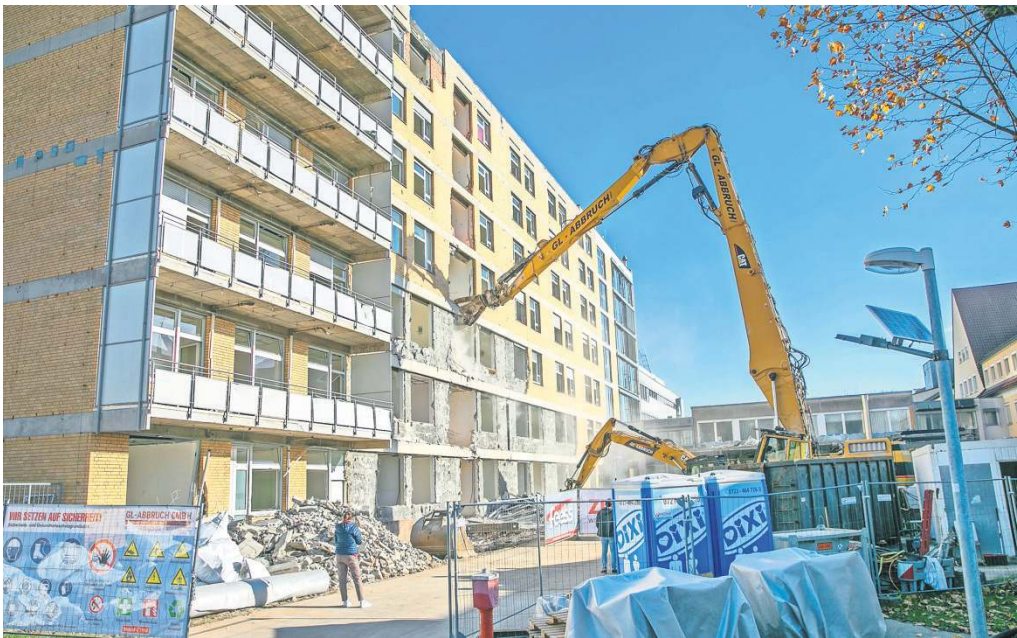
Mit einem symbolischen Abrissbaggerbiss wird der Neubau eines zentralen Klinikum-Gebäudes eingeläutet. Foto: Roberto Bulgrin
