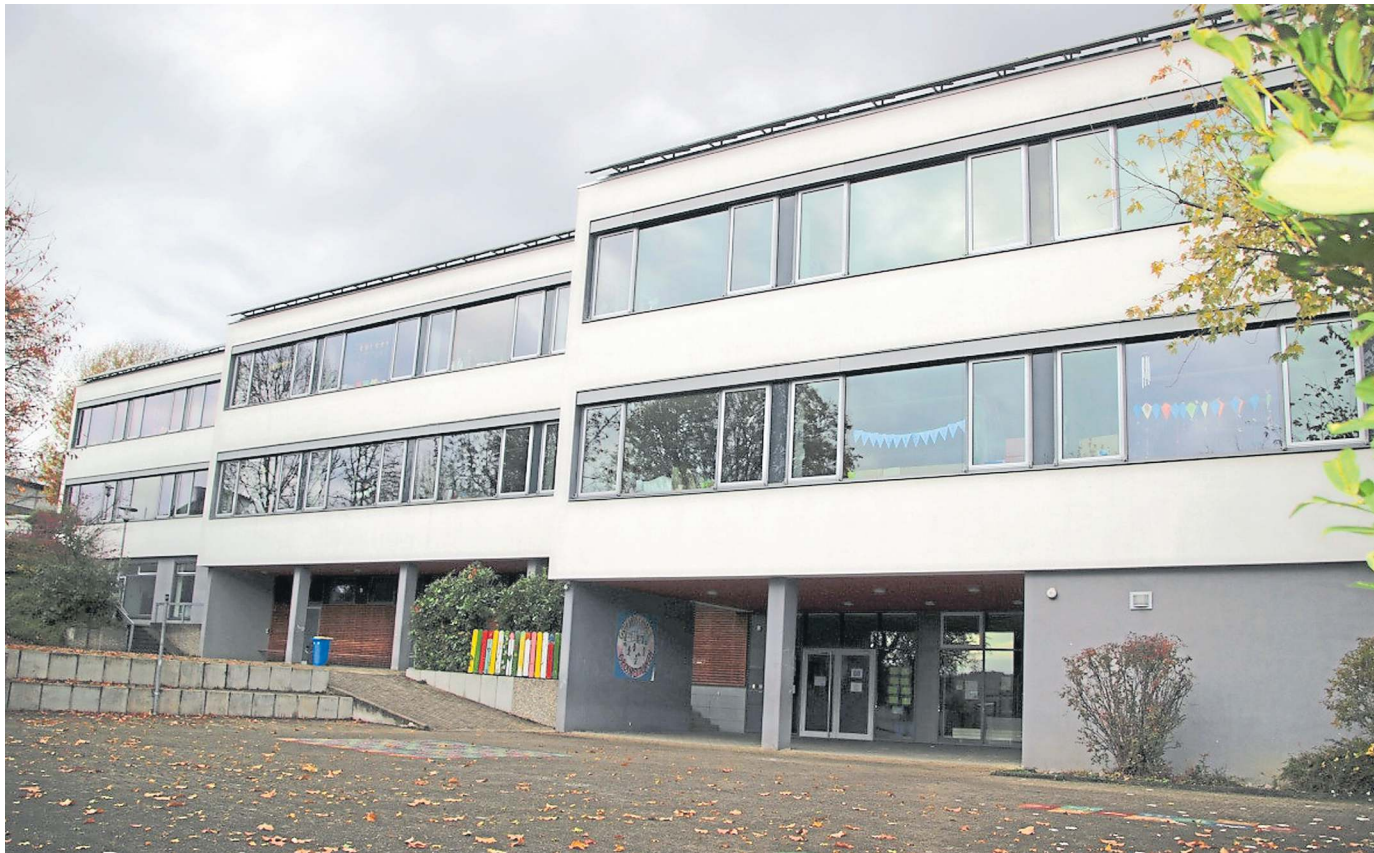
Die ehemalige Hauptschule soll fit gemacht werden für die Zukunft: Hier zieht die Ganztagsbetreuung ein.
