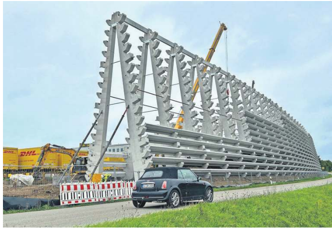
In Köngen wird eine bis zu 16 Meter hohe Lärmschutzwand errichtet. Foto: Kerstin Dannath
